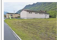
Der heutige Kindergarten am Sportplatzweg soll durch einen Doppelkindergarten ersetzt werden. Bild: Josias Clavadetscher
